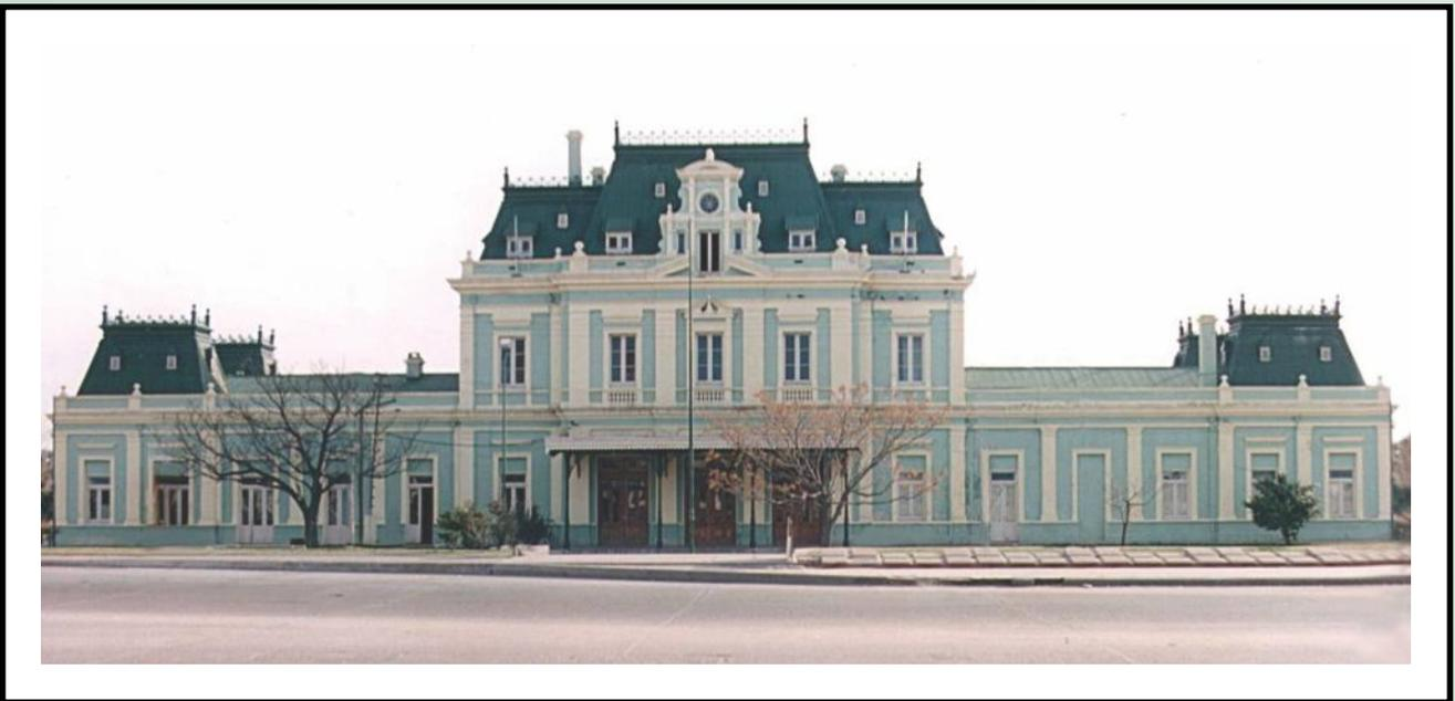
"El edificio tendrá un largo de 63 m., con un ancho de 13,80 m.. Consistirá de una parte central de dos pisos, con dos aleros de un piso.
