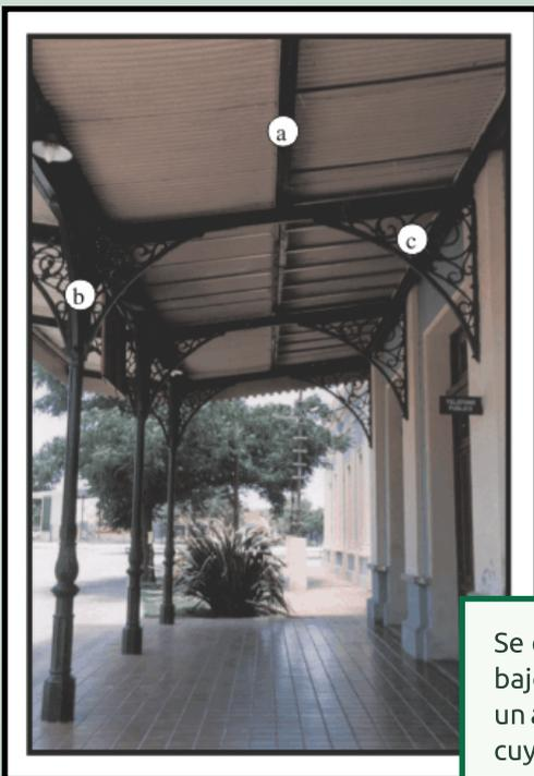
Los británicos, a partir de la Revolución Industrial, utilizaron en todo el mundo la llamada "arquitectura utilitaria del hierro" en construcciones tales como estaciones ferroviarias, mercados, naves de fábricas, etc. Estas estructuras metálicas, y en algunos casos hasta los ladrillos, eran embarcados desde Gran Bretaña y conducidos a distintos puntos para ser armados.
